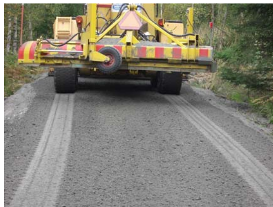
Figur 5b: Färdig blandning av flygaska och grus.
