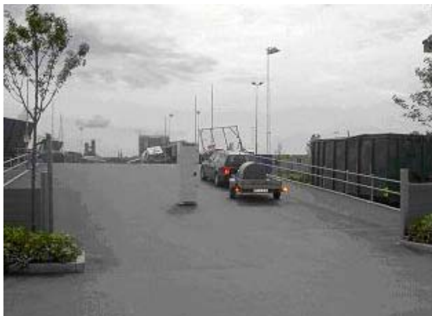
Figur 9: Färdigställda körytor och uppkörningsramp, våren 2002
