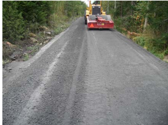
Figur 7: Packning med vibrovält
