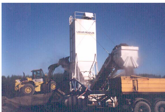
Figur 2: Tillverkning i stationär blandningsstation
