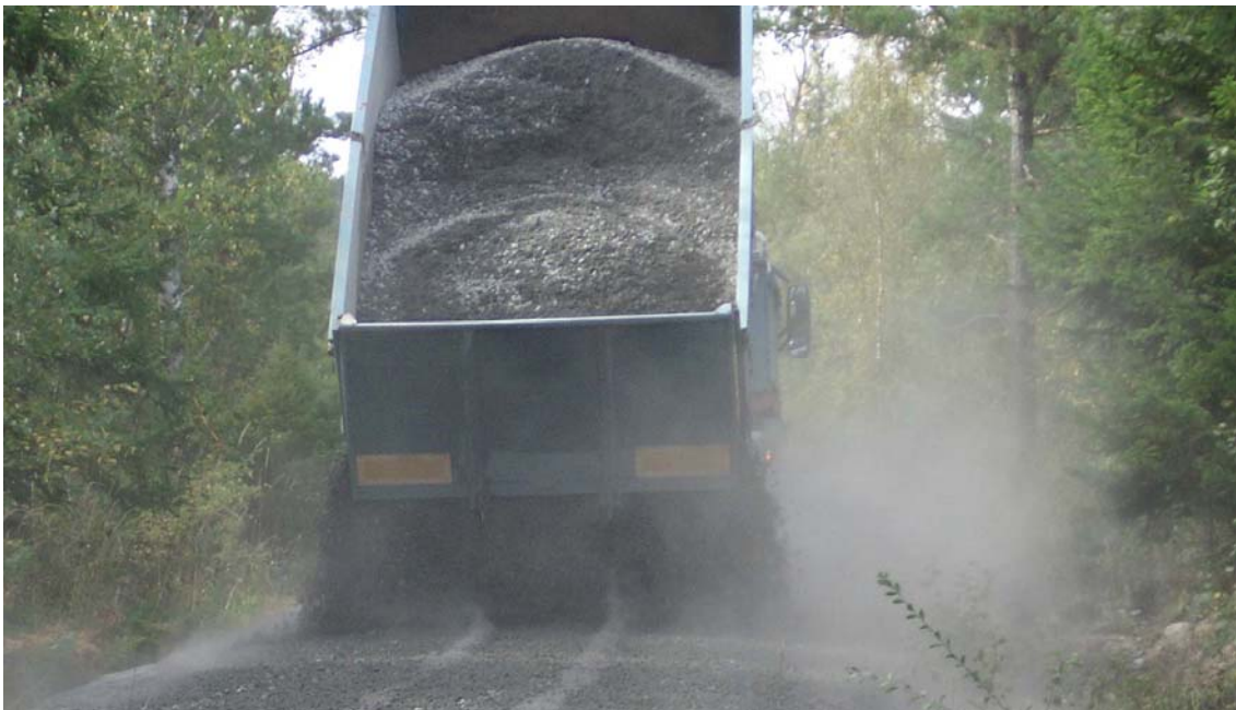
Figur 8: Slitlager av grus påförs.
