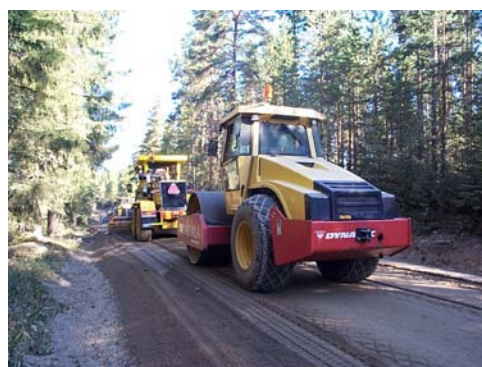
Figur 6: Packning av slitlager
