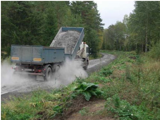
Figur 6: Utläggning av flygaska
