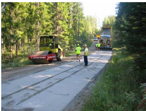
Figur 3: Flygaska före infräsning i befintlig väg
