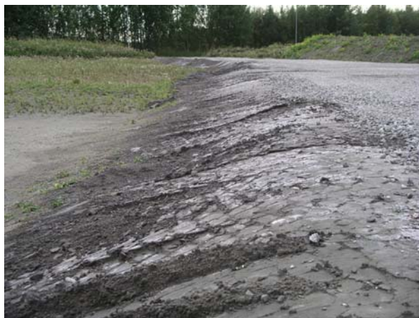
Figur 8: Släntlutning som möjliggör packning av materialet
