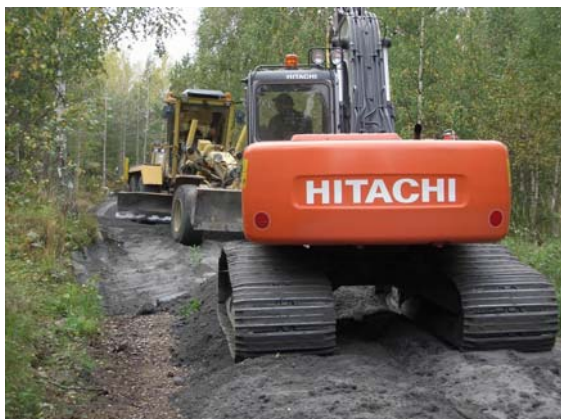
Figur 5a: Utläggning av flygaska
