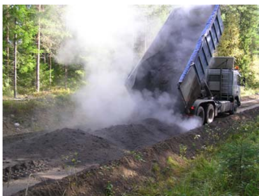
Figur 2a: Utläggning av flygaska
