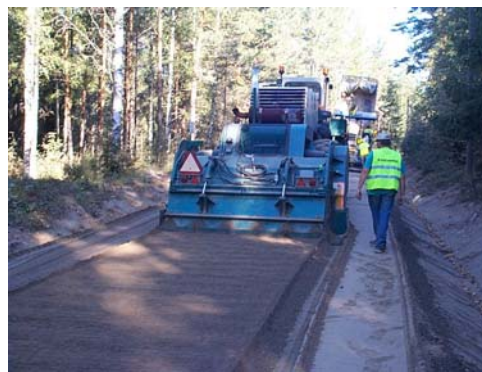
Figur 4: Infräsning till 0,2m djup i befintlig väg
