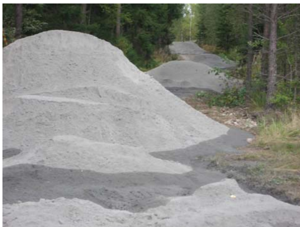
Figur 4: Flygaskan utlagd i högar med ca 20 – 30 m mellanrum.
