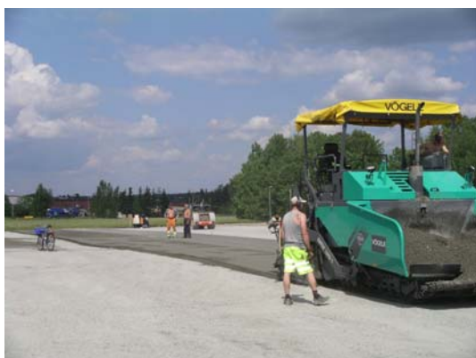
Figur 10a: Läggning av markbetong
