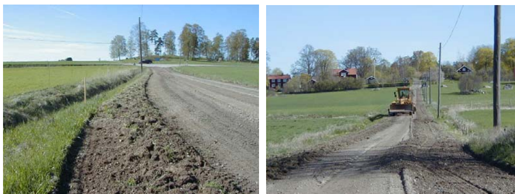
Figur 14 & 15: Indragning av kanter, central åtgärd vid förstärknings- och underhållsarbeten av grusvägar, för att förbättra avvattning av konstruktionen.
