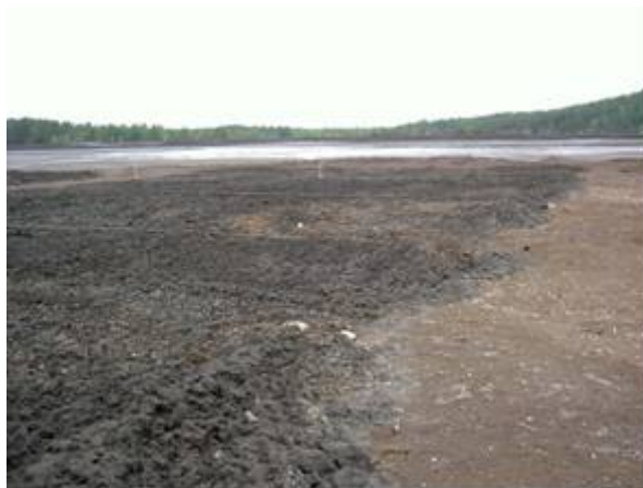
Figur 6. Täcksikt av rötslam (25 eller 50 cm tjockt) på ett tätskikt av bioflygaska vid Gillervattnet, 2005.
