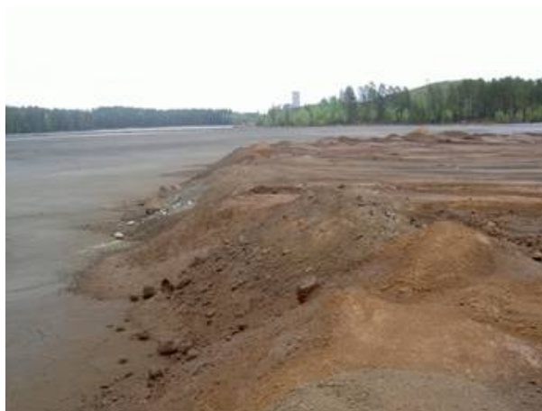
Figur 5. Utläggning av ett 0,5 m tjockt tätskikt av bioflygaska på Gillervattnets anrikningssandmagasin, 2003.
