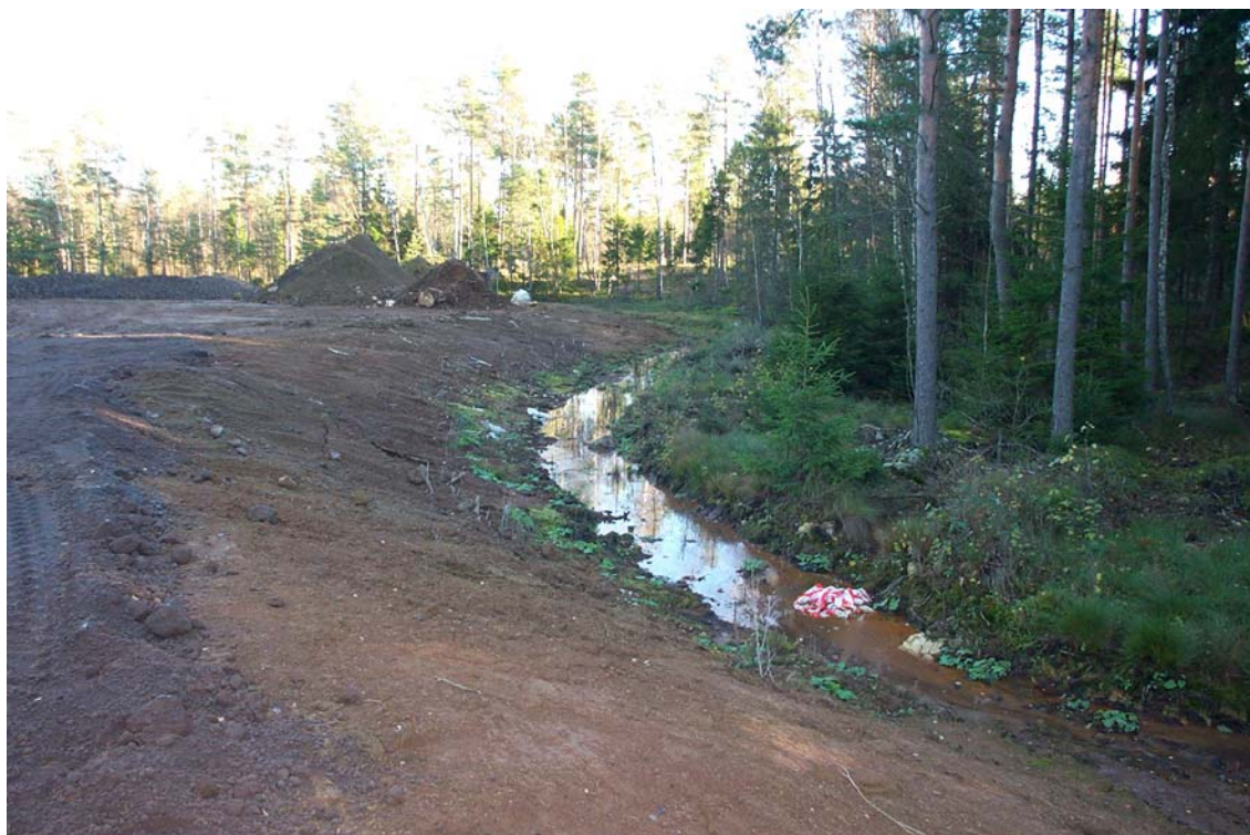
Figur 2. Släntning mot de kringliggande diken. Vy mot öster.
