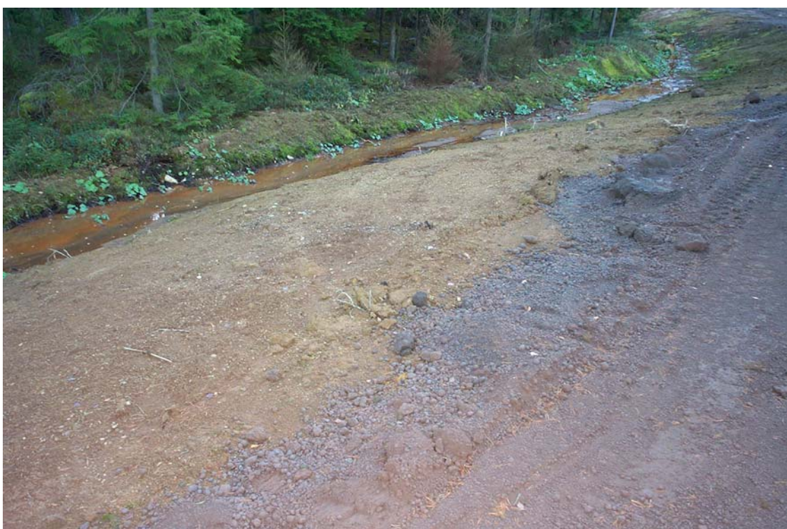
Figur 1. Illustration över hur det granulerade rötslammet är pålagt som vegetations-etableringsskikt över blandningen mellan aska och rötslam.
