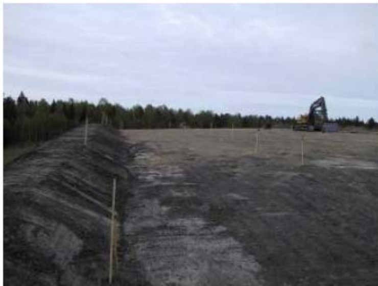
Figur 1. Avjämningsskikt på försöksytan på Dragmossen deponi [1].
