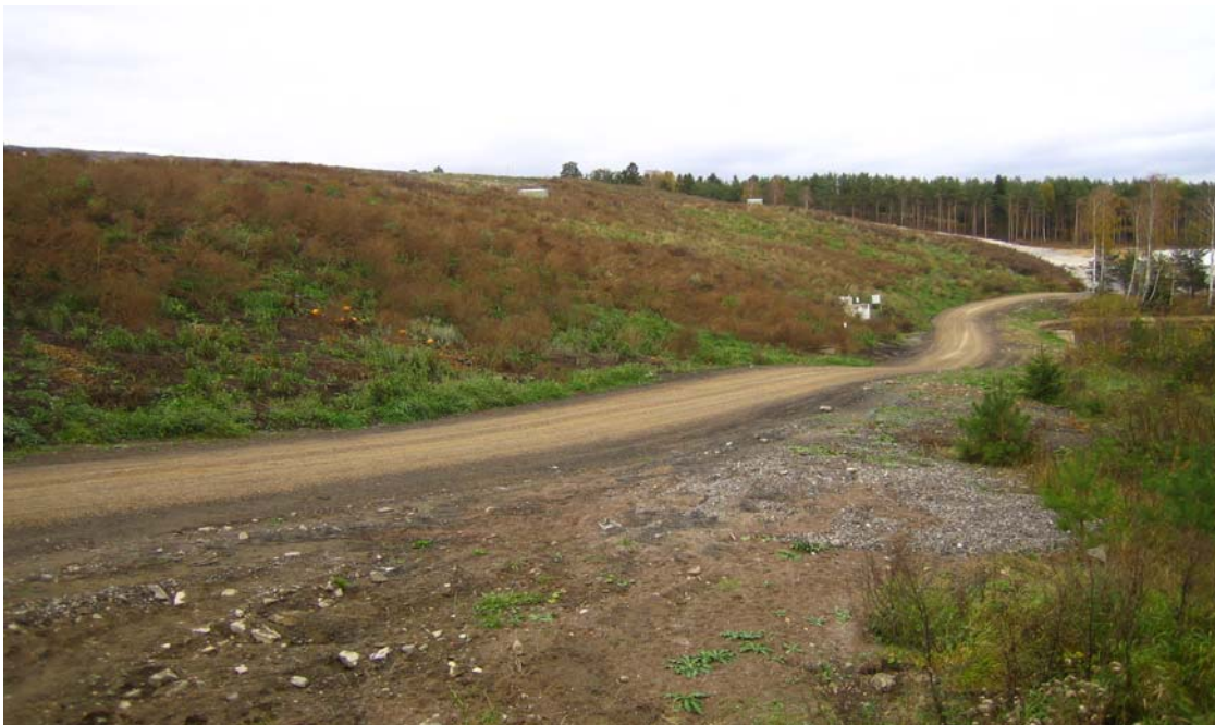
Figur 12. Fyra hektars sluttäckning på Tveta Återvinningsanläggning med insäddning av gräs (röda prickar är stora pumpor). På övre ytan syns två inloggningsbodav lysimeterdata. (Foto: Gustav Tham, 18 oktober 2005).
