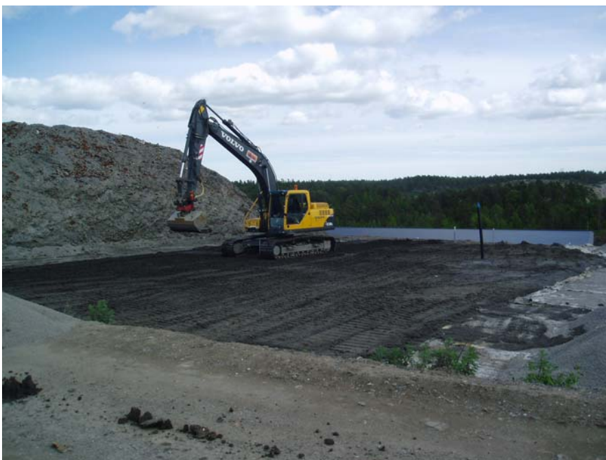
Figur 9. Utläggning av aska/slam-blandning på Sofielund som tätskikt ovanpå avjämningskiktet av bottenaska.
