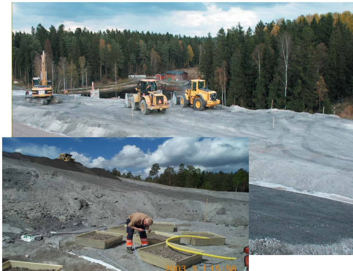
Figur 11. Utsättning av lysimeterar under tätskiktet och utläggning av aska i tätskiktet. (Foto: Gustav Tham, Rolf Sjöblom, aug 2004)
