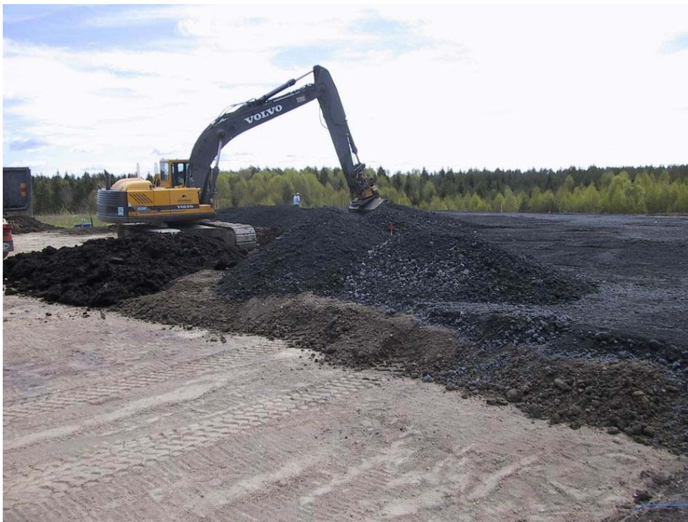
Figur 8. Utläggning av aska/slam-blandning som tätskikt på deponin Dragmossen.
