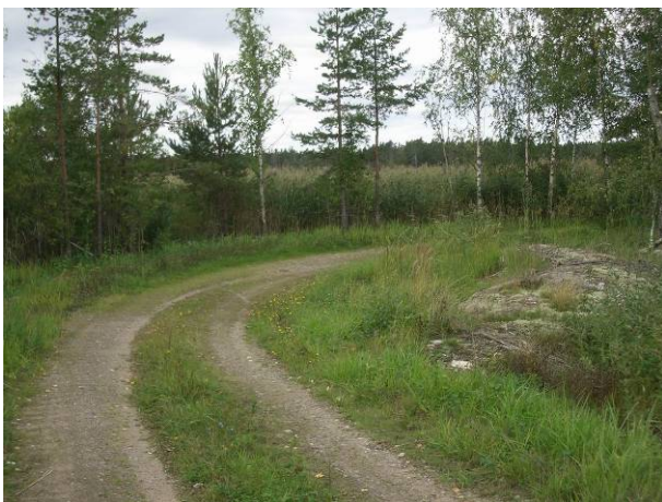
Figur 2 Typisk sträcka på Ehnsjövägen före renovering.
