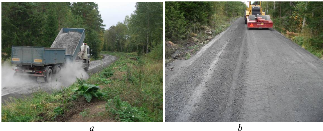
Figur 12 Utläggning av flygaska med "grusbil" (a) och packning med vibrovält (b). Figure 12 Tipping of fly ash from a gravel truck (a) and compaction of the road (b).
