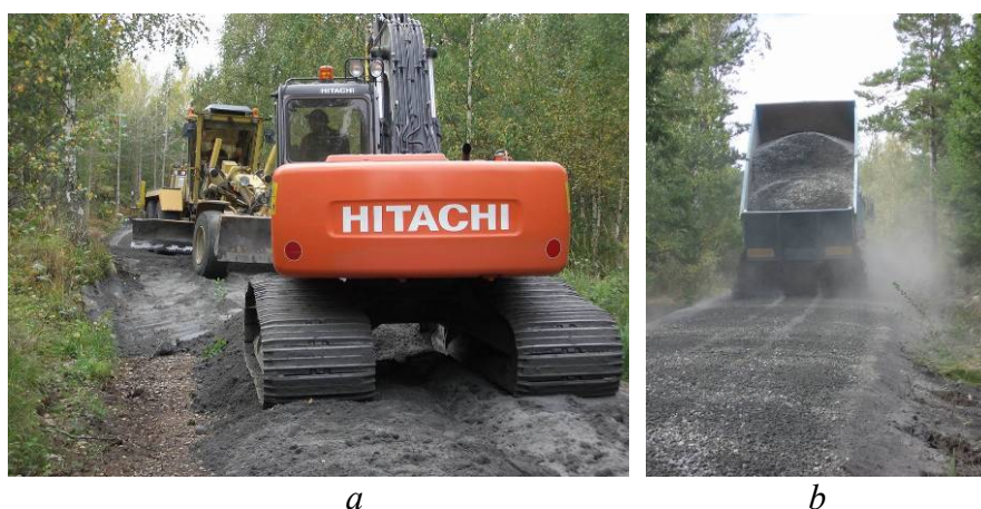
Figur 10 Avjämnning av flygaska (a) och utläggning av grusmaterial (b).
