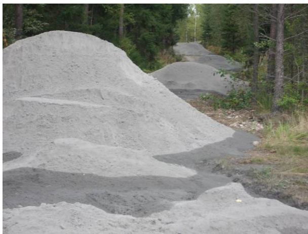
Figur 4 Flygaskan utlagd med ca 20 – 30 m mellanrum.
