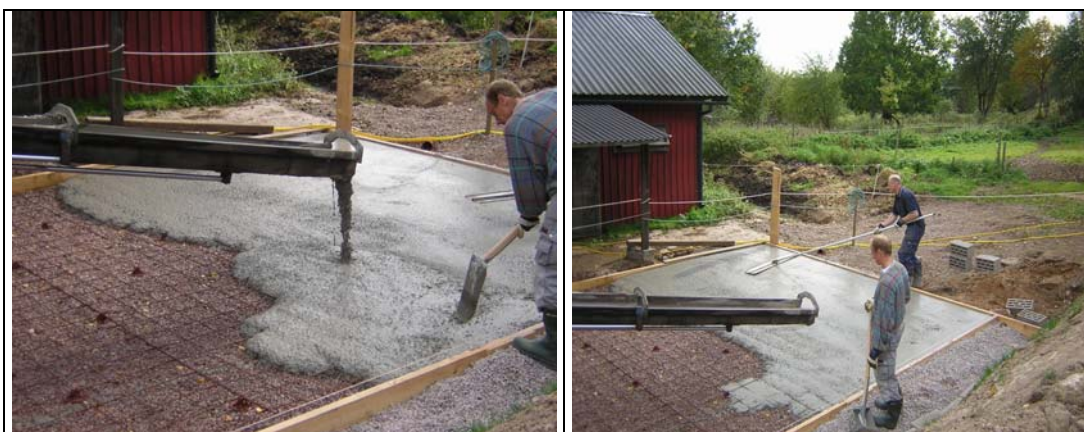
Figur 15. Teknikdemonstration med självkompakterande betong i bottenplatta gjutning i Tranås
