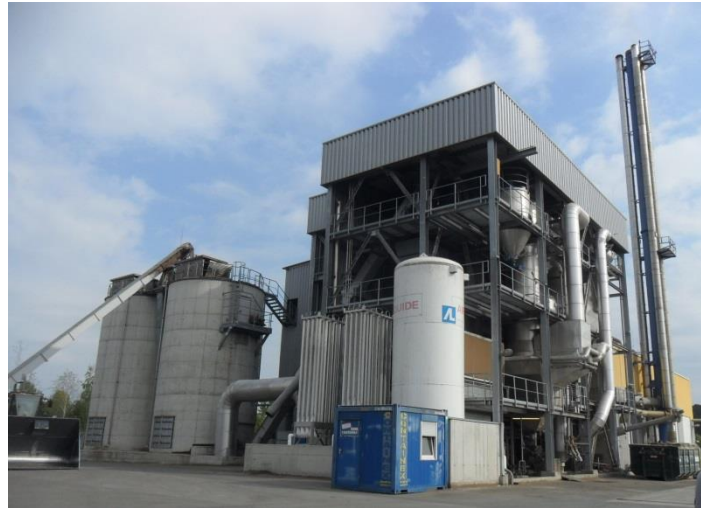
Figur 5. Foto av Obertwarts kraftvärmeanläggning i Österrike, där syngas produceras från förgasning av flis som sedan förbränns i Jenbachers gasmotorer till kraftvärme. Foto: Anna-Karin Jannasch.
