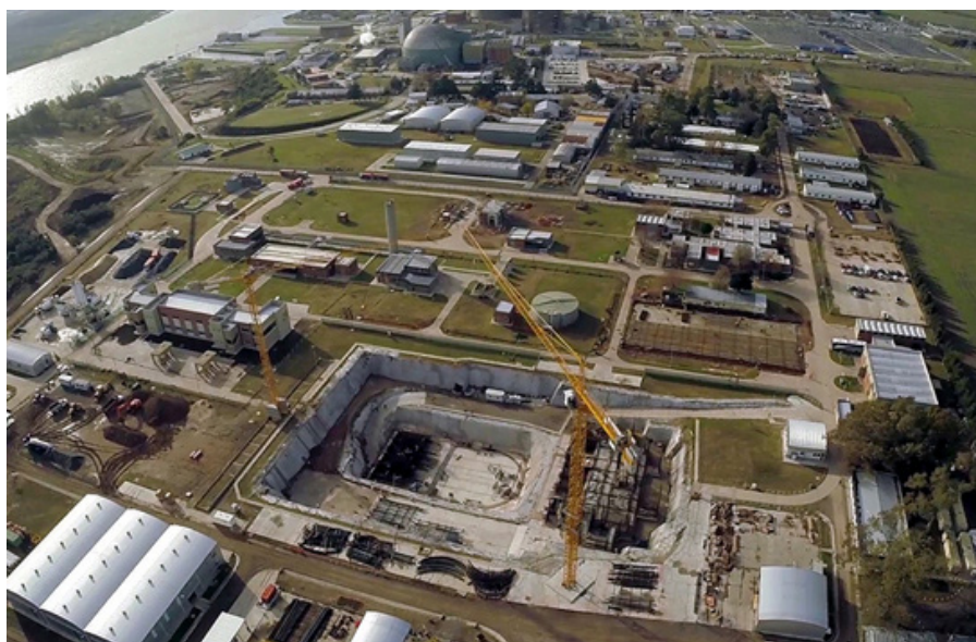
Fotot visar byggnationsplatsen för den planerade CAREM-reaktorn i Argentina. Foto: CNEA
