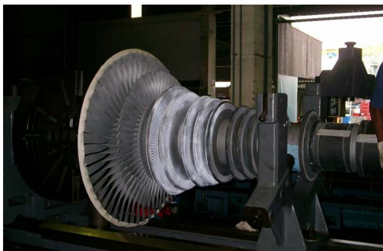
Figur 30. Kiselbeläggningar i en ångturbin (utan mellanöverhettning)
