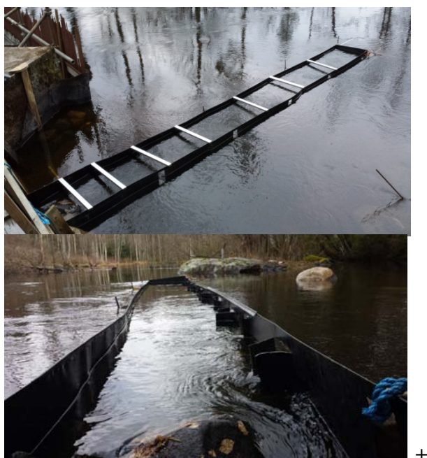
Figur 12 U-ränna med vertikala sidor och spaltöppningar på den högra sidan.
