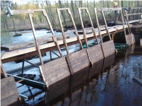
Figur 8 Öppningar mellan sättar för försöksuppställningar i den östra sidan av Trässhultsån.
