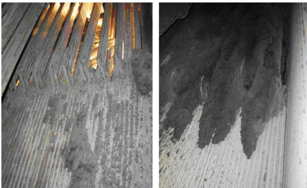
Figur 23. Beläggningar på screen-tuberna före (vänster) och efter (höger) halmeldning
