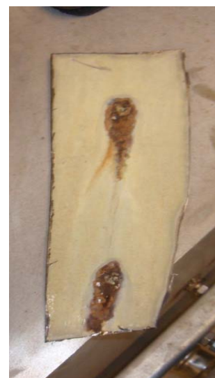
Fig. 12 Pitting på insida av rökrör
