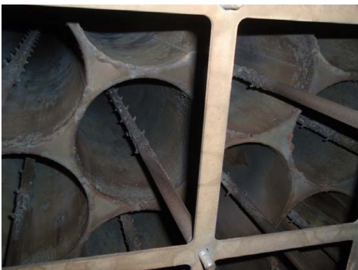
Fig. 11 Emissionselektroder i rökrör i vått elfilter (saltspärr)
