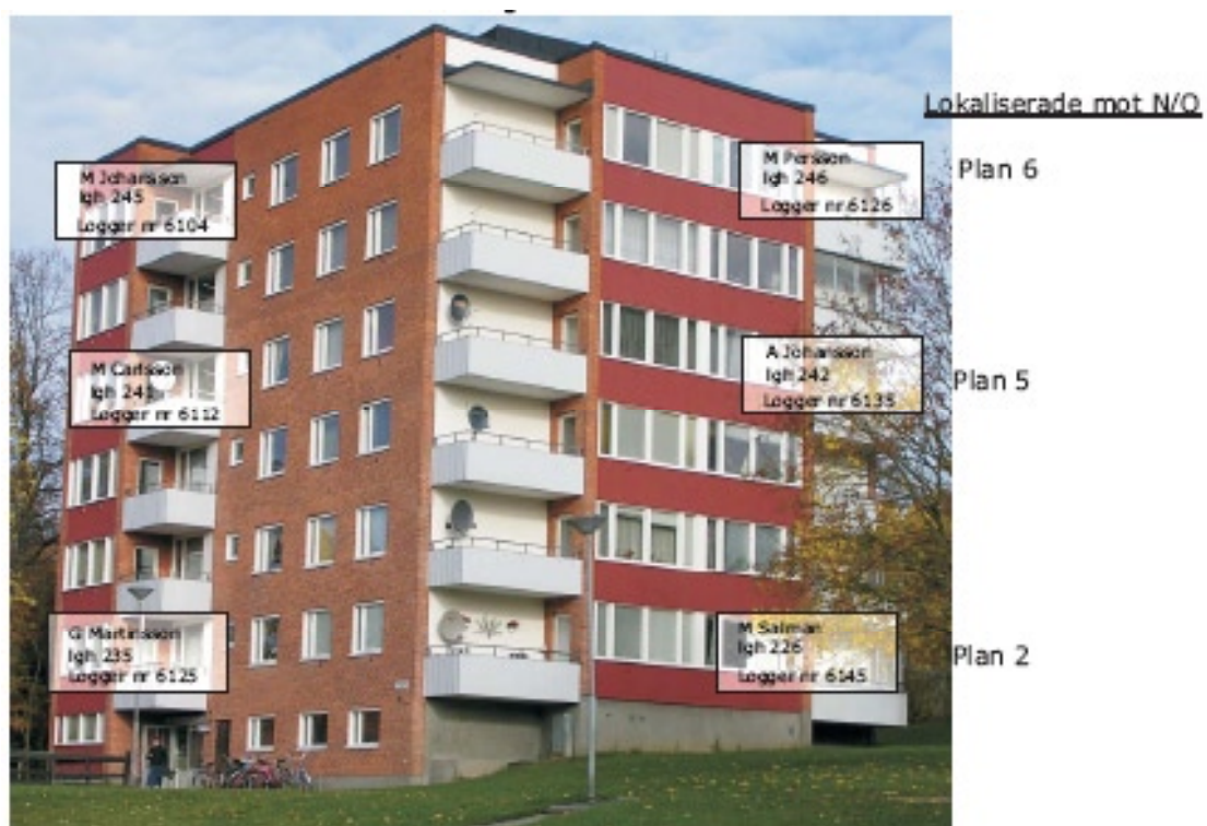
Figur 3.3 Utplacering av temperatursensorer.
