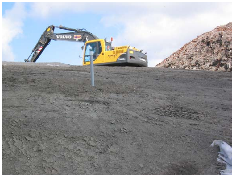
Figur 4.3 Packning av utlagt FSA med bandgående fordon, SRV återvinning.
