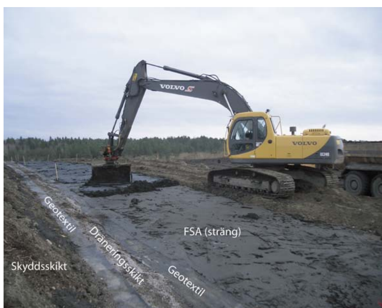
Figur 4.2 Exempel: Utlagt FSA-, dränerings- och skyddsskikt, Lilla Nyby, Eskilstuna.
