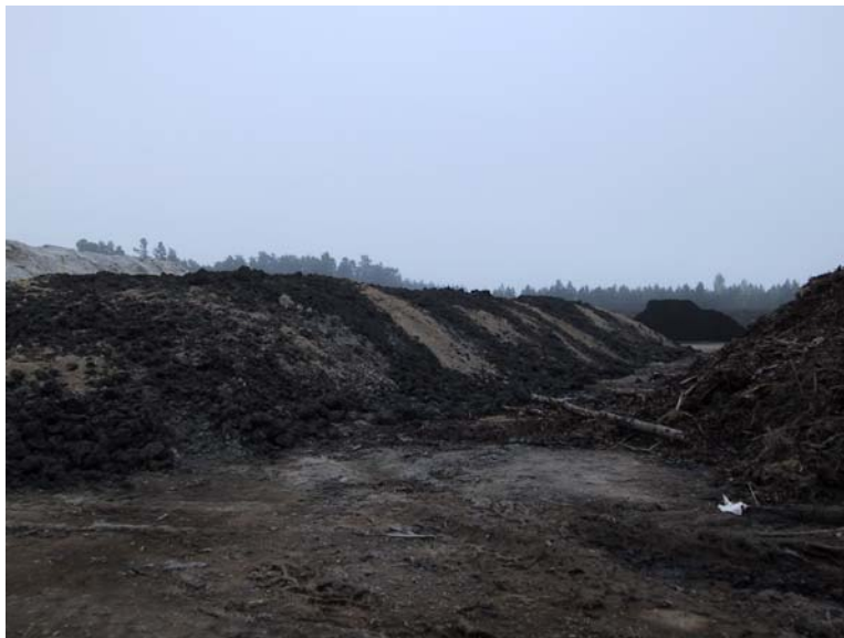
Figur 4.1 Exempel på lagring av slam. Limpans bas är ca 6 – 8 m, höjd ca 3 – 3,5 m och längd ca 25-30 m, Dragmossens deponi.
