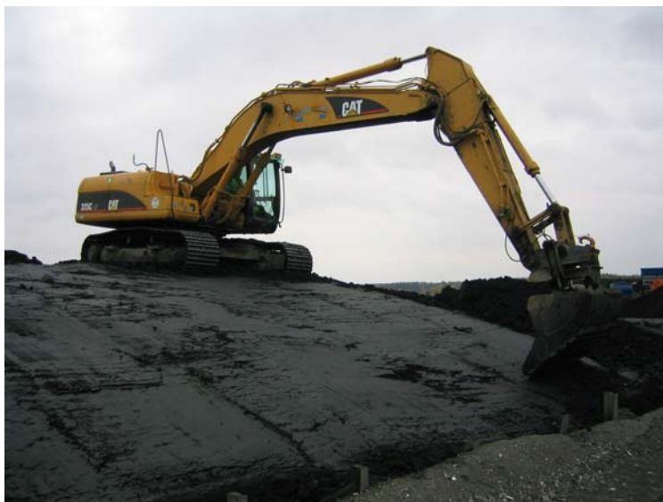
Figur 3. Packning med skopa i slänt.
