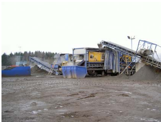
Bild 2. Metallbitar sorteras bort av anlitad entreprenör.
