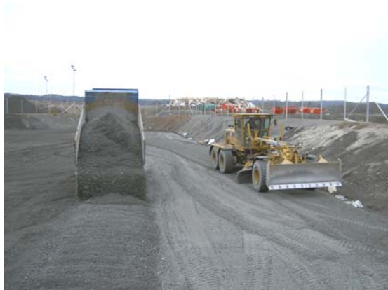
Bild 7. Lastbilen fördelade materialen medan vägghyveln jämnade till.
