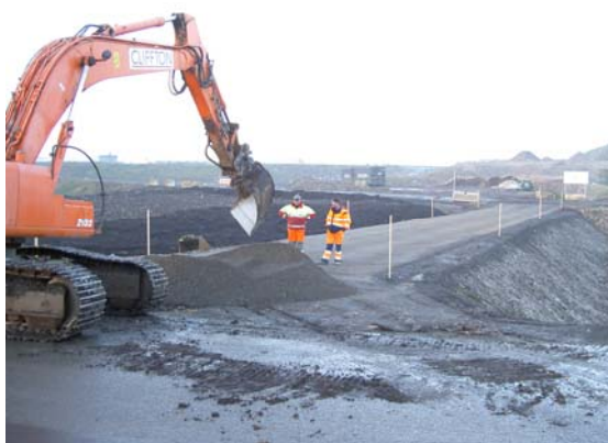
Bild 11. Anslutningarna byggdes med resterande SLAGG-produkter.
