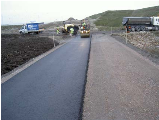
Bild 13. På grusbärlagrets lades först ett lager AG 16.
