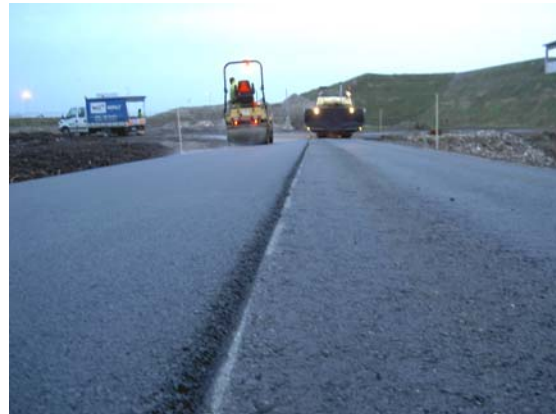
Bild 14. Som slitlager lades 30 mm ABT 11.
