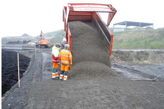
Bild 9. Respektive bärlagermaterial spreds på utstakade avsnitt.
