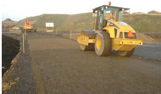
Bild 12. Lagren packades med vibrerande vält.
