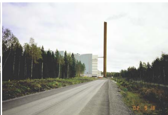
Bild 2. Provväg uppbyggd med slaggrus och med inlagda lysimetrar för uppsamling av lakvatten (ett tidigare försök).
