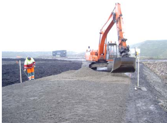
Bild 10. Materialen breddes ut med laserstyrd grävmaskin.
