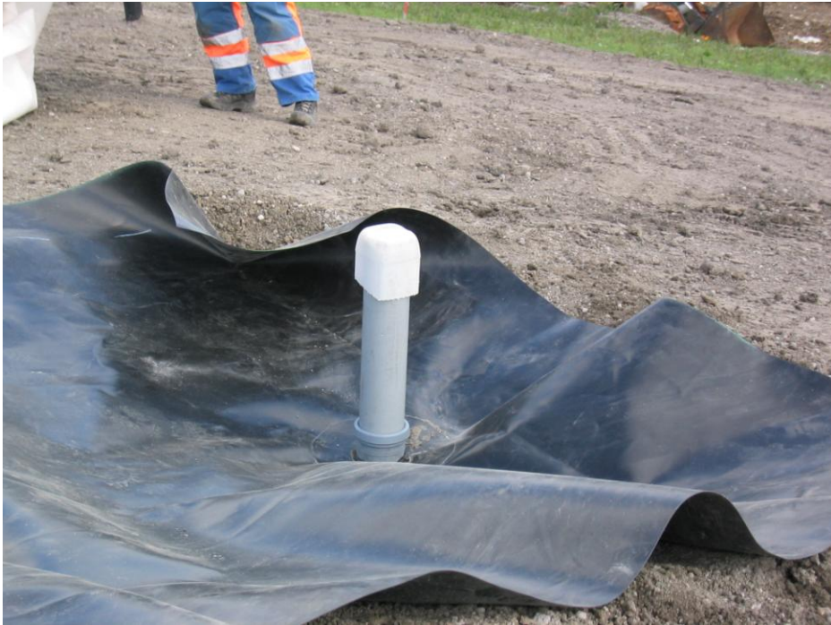
Figur 1-4 Installation av lysimeter på SRV:s provyta, Sofielund.
