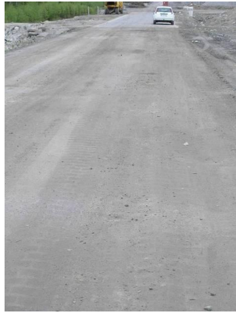
Grundvattenrör 4 syns inte i vägbanan.
