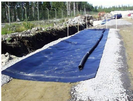
Figur 11. Dåvavägen hösten 2001, utlagd lysimeter i en av sträckorna.
