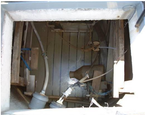
Provtagningsbrunn 2 vid asksträckan.
