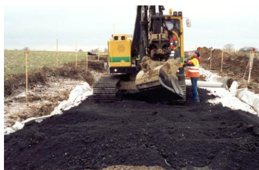
Figur 5. Törringevägen, utläggning av slaggrus på provsträckan i november 1998.
