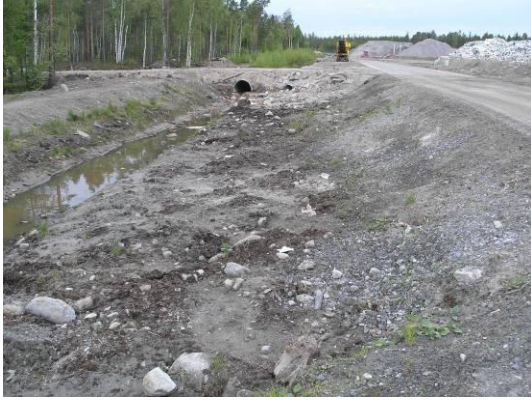
Här ska grundvattenrör 1 och 3 sitta.
