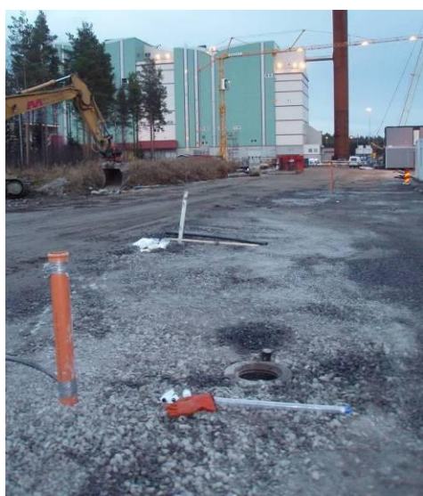
Figur 32. Dåvavägen i oktober 2007. Vänster: Grundvattenrör 1 och 3 som ursprungligen sattes i den södra vägs slänten. Höger: Grundvattenrör 1 är kapat och täckt med ett brunnsluck.
