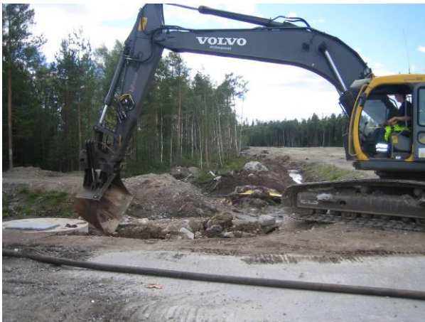
Grävning av nytt utlopp till brunn 2 vid asksträcken.
