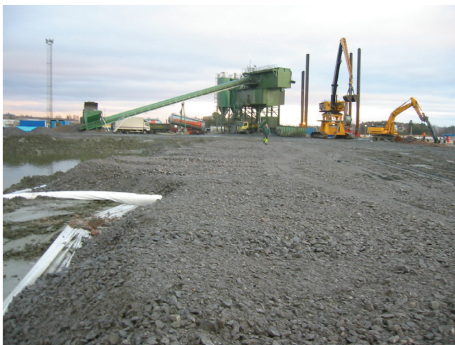
Figur 7.1 Terminalyta under uppbyggnad i Åbo.s/s behandling av förorenade sediment med process-stabilisering (bild A. Majjala).
