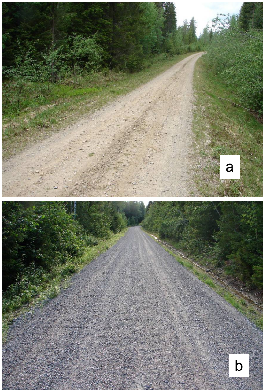
Figur 5. a) Vägen innan uppgradering b) Vägen efter uppgradering med aska
