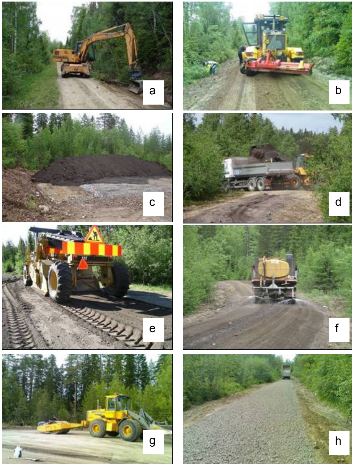
Figur 2. Anläggning av ask-grusvägen a) dikesjustering, b) hyvling av vägen, c) askuplag, d) lastning av aska på grusbil innan askutläggning, e) fräsning, f) vattning, g) packning, h) utläggning av slitlager.
