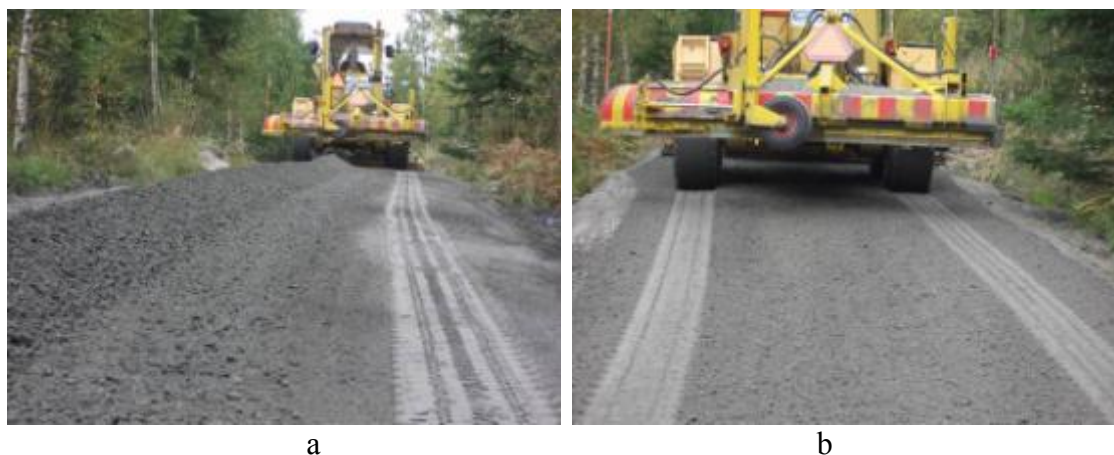
Figur 4 Homogenisering av grus och flygaska(a) och den färdighyvlade vägytan(b).
