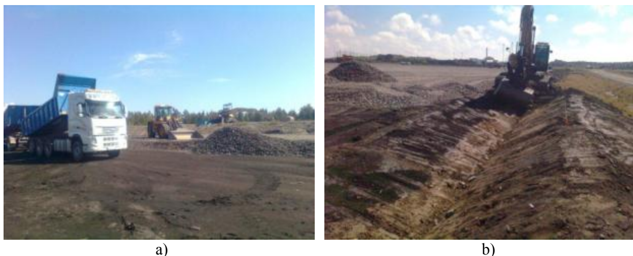
Figur 5.16. Anläggningsarbetet på Dåvamyrens Industripark, a), utläggning av förstärkningslager ovanpå konstruktionsdelen med bioaska och b) utloppsdikey och vall av morän.
