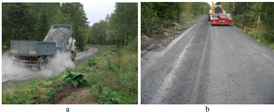
Figur 5 Utläggning av flygaska med ”grusbil” (a) och packning med vibrovält (b).
