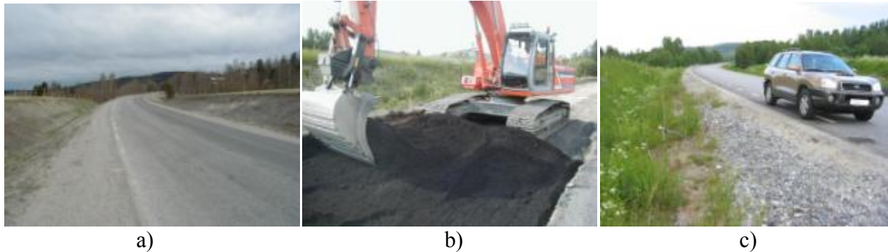
Figur 5.2. a) Provsträckan 2001 innan åtgärd, b) under arbetets gång sommaren 2001 och c) 2003. Figure 5.2 a) The road before stabilization 2001, b) stabilization during summer 2001 and c) the road section 2003.
