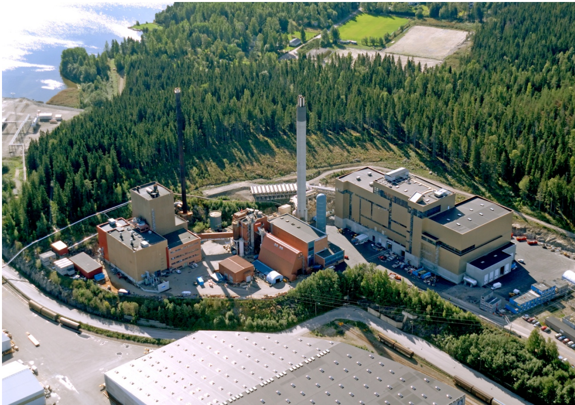
Figur 2. Korstaverket, Sundsvall Energi.
