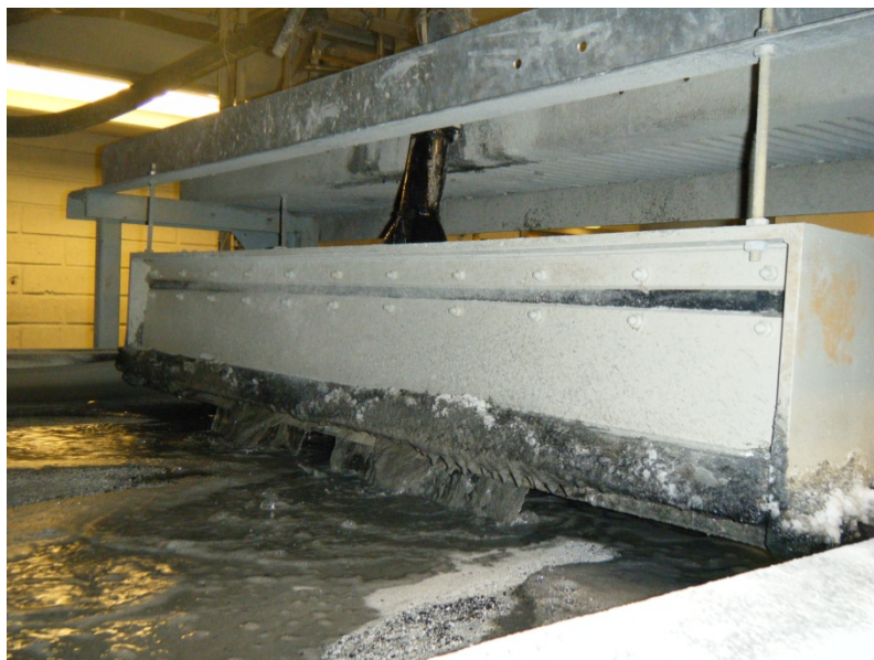
Figur 15. Utläggning av askslurry på bandfiltret vid fullskaleförsök.
