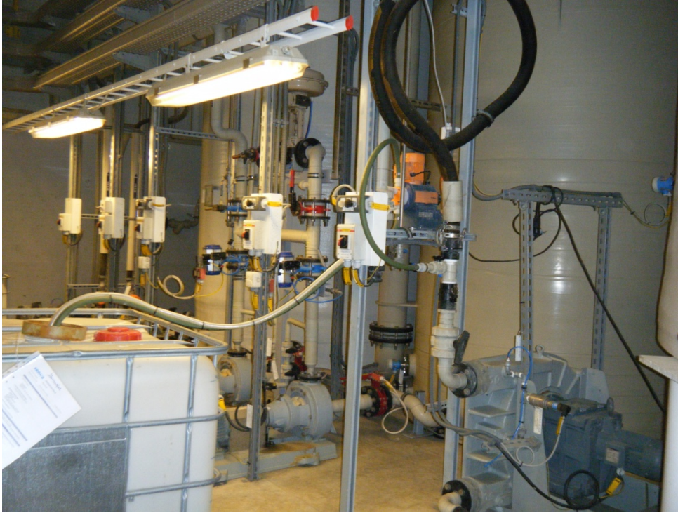
Figur 14. Dosering av järn(II)sulfat till slamförtjockaren vid fullskaleförsök.
